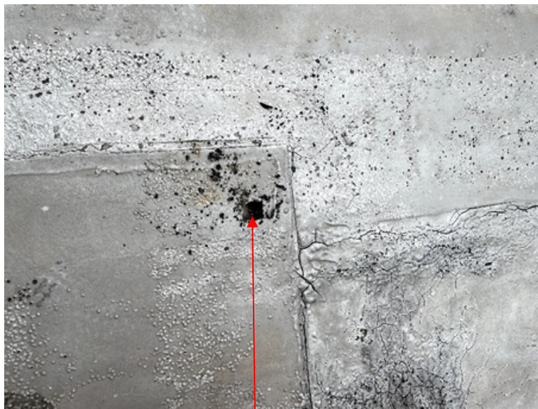
Provedení sondy do střešního souvrství
