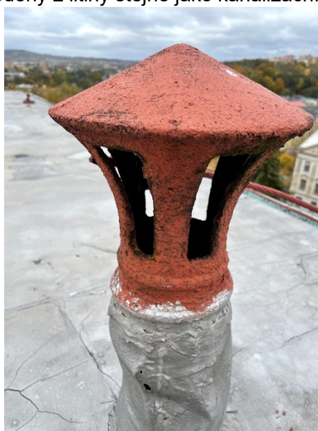
Hlavice odvětrání kanalizačních rozvodů
